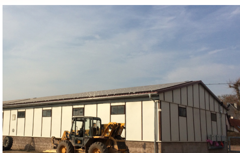
Fertiggestellte Anlage mit 1.648 Modulen
