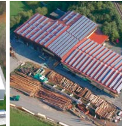
Photovoltaikanlage Schauenburg 116 kWp PV-Anlage
