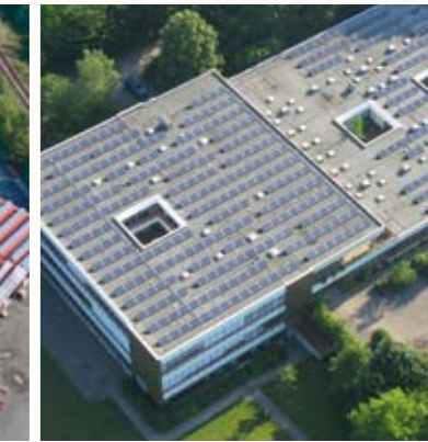
Photovoltaikanlage Göttingen 184 kWp PV-Anlage
