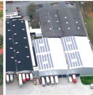
Photovoltaikanlage Kassel 92 kWp PV-Anlage
