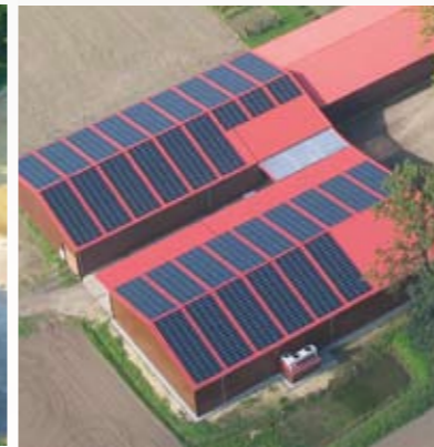
Photovoltaikanlage Bergen 174 kWp PV-Anlage
